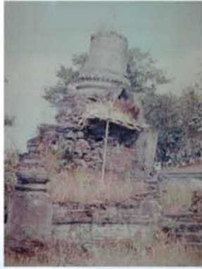
เจดีย์เก่าก่อนบูรณะ
